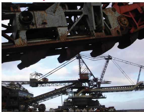
Der neue Radweg Kohle | Dampf | Licht führt unmittelbar zu den stählernen Kolossen der „Stadt aus Eisen“ bei Gräfenhainichen.
