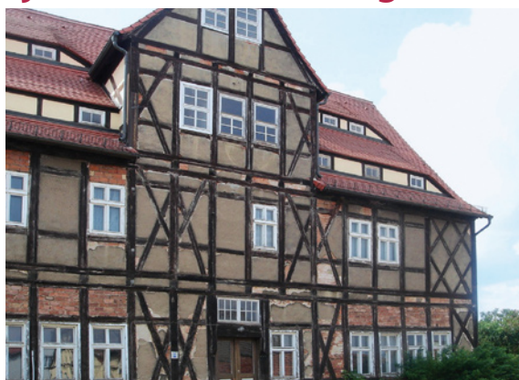
Bisher nicht genutzte Gebäude in Ortsteilen der Stadt Jessen sollen für generationsübergreifende Begegnungsangebote umgebaut werden. (Foto: ehemaliges Amtshaus im Zentrum von Schweinitz)
